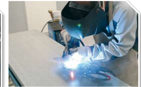
10 Realizar soldadura en probetas para comprobar parámetros.
