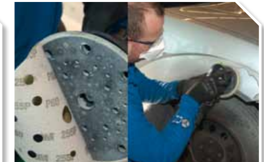
10 Realizar acabado de la zona lijando con P80 para eliminar pequeñas imperfecciones residuales del reconformado
