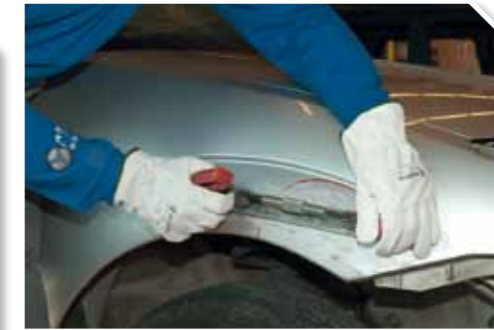
6 Verificar el estado de la reparación manualmente y con la lima de carroceró
