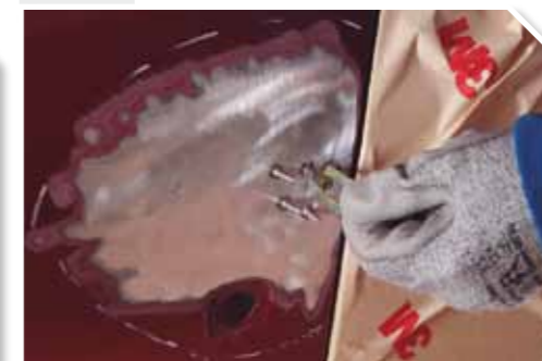
7 Colocar las arandelas en los pernos
