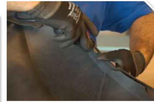
6 Insertar la grapa sobre la parte interna de la rotura
