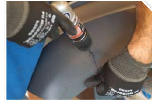
4 Acotar mediante un taladrado el extremo de la grieta
