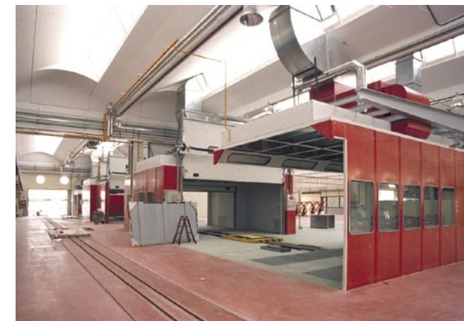
Cualquier tipo de obra en el local requiere de una licencia municipal de obras.
